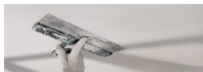
Płyta GK wykończona
